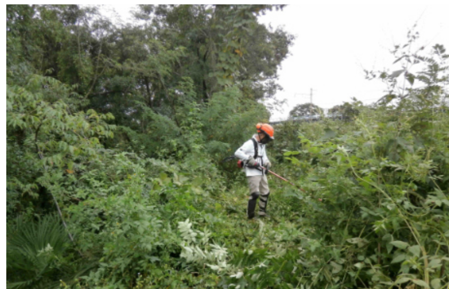
作業内容の確認
